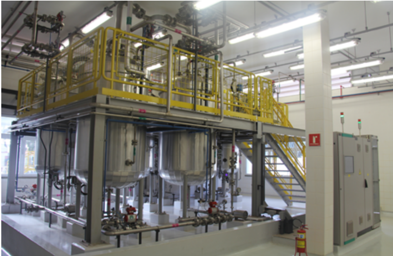
Planta do SENAI possui maior capacidade de realização de pesquisas, simulações, análises e extrações de dados do que qualquer planta convencional. Tudo pronto para a chegada da Indústria 4.0
